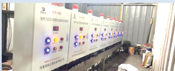
建材厂安全联锁安装现场
