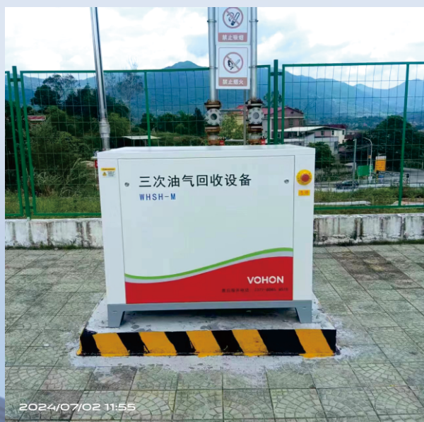
加油站三次油气回收设备 气量：6-20Nm 3 /h 废气：油气
