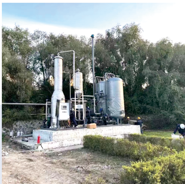
油库油井油气回收设备 气量：400Nm 3 /h 废气：油气
